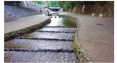
一条戻橋付近の堀川
