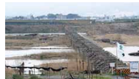
上津屋橋(ながれ橋)
