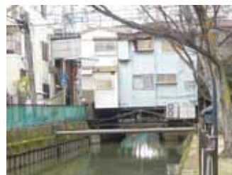
友呂岐悪水井路橋上の建物
