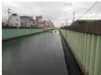
住道付近の鋼管杭護岸
