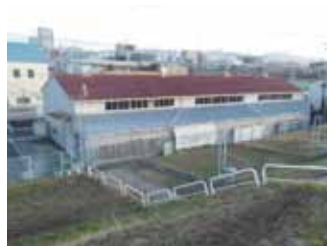
木屋揚水機場
