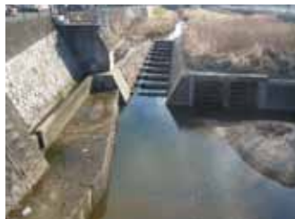
落差工上流側の魚道
