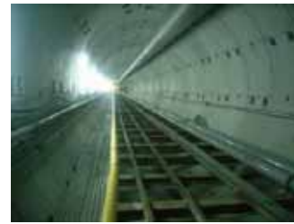
寝屋川北部地下河川 (大阪府ホームページより)
