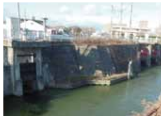
ポンプ場(右)と下水処理水の放流口(左)
