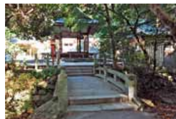
修学院離宮内に架かっていた御幸橋 (鷲森神社)
