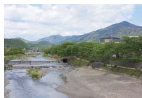
高野川と東岸の第1疏水分線水流出口
