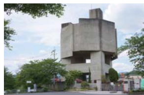
松ヶ崎浄水場
