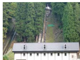
黒田発電所と水路
