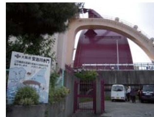
大阪府安治川水門
