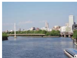
川崎橋と寝屋川(右側)
