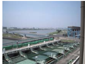
毛馬排水機場(上方に淀川、右側に毛馬水門)
