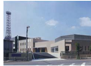
津波・高潮ステーション全景
