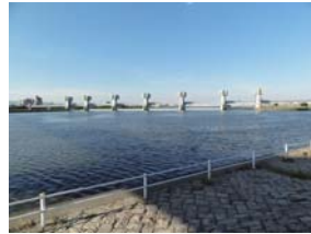
新淀川下流左岸側から見た淀川大堰
