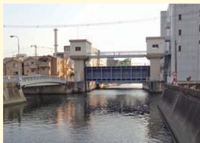
平野川分水路排水機場
