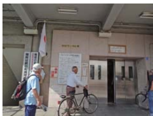
安治川トンネル
