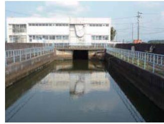
守山南部地区の逆水灌漑施設
