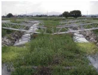
志那中内湖に設置されている浮遊式水生植生帯
