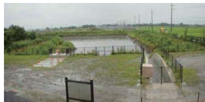
守山川河口の降雨時流出水の一時的貯留池
