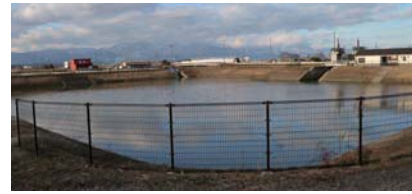
天神川河口の降雨時流出水の一時的貯留池
