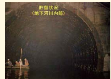
〔寝屋川南部地下河川〕
