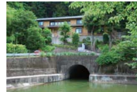
諸羽トンネル出口
