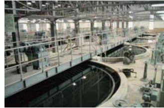
日本最初の急速ろ過池
