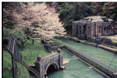
第二疏水出口(下)、第一疏水(上)と御所水道ポンプ室
