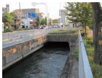
鴨川運河の地下化
