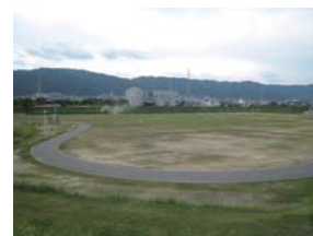
恩智川(花園)多目的遊水池
