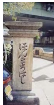
本町橋の江戸時代からの橋柱
