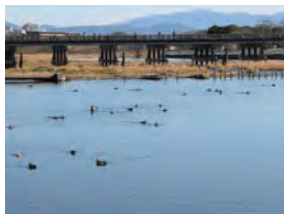
一の井堰の遠景
