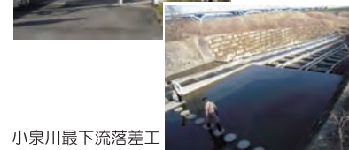
小泉川最下流落差工
