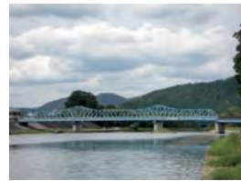
大堰橋（八木大橋）
