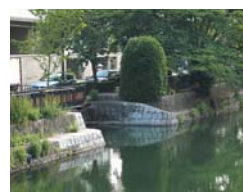
仁王門橋と流量調節堰
