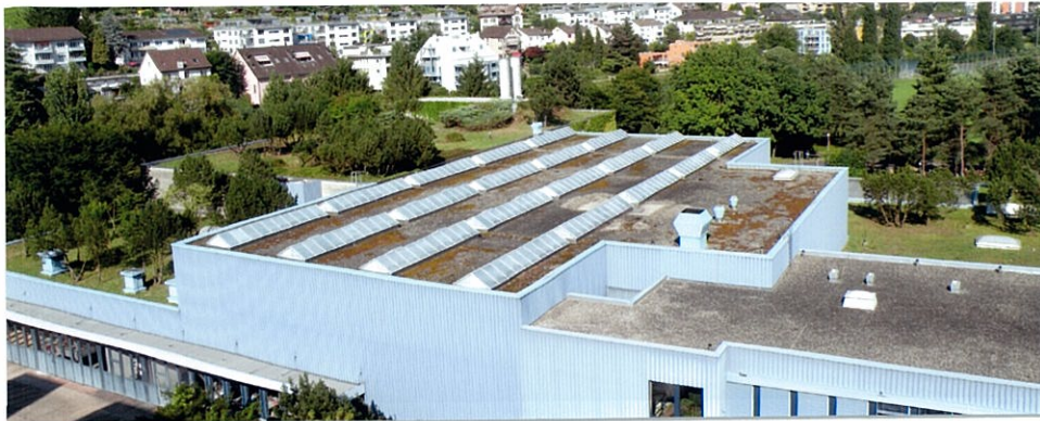
ハルトホフ浄水場
