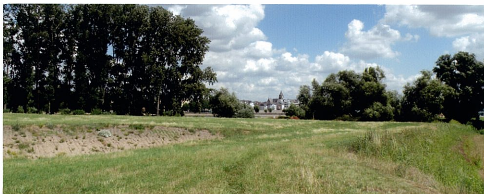
ネットテ川河口の自然再生工事施工後
