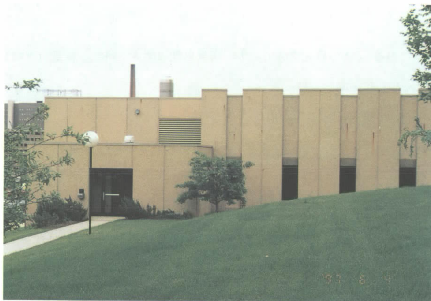
有害物質研究棟
