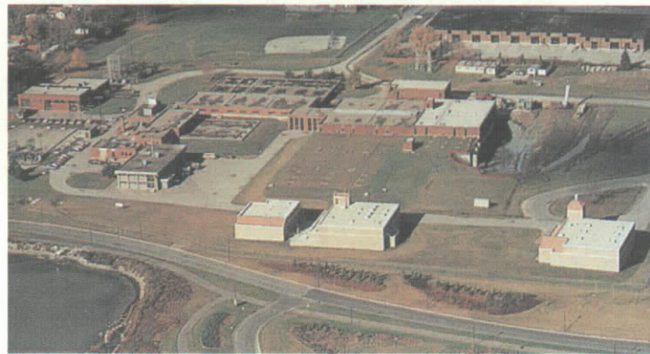
レーク・ビュー浄水場の全景
