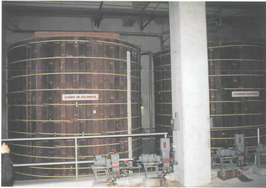
ローン・パーク浄水場の薬品貯留タンク（硫酸アルミニウム用）
