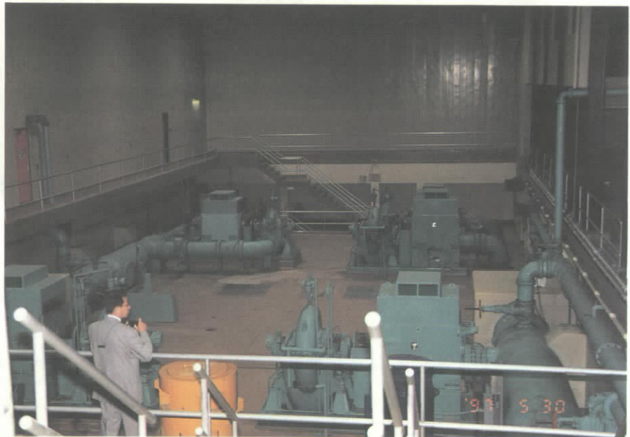
ローン・パーク浄水場の ポンプ室
