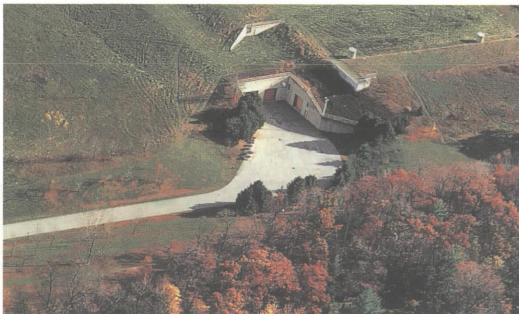
ローン・パーク浄水場
