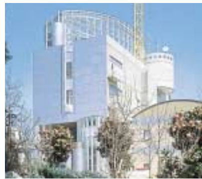
下水道のしくみとはたらきがわかる、大阪市此花区の下水道科学館
