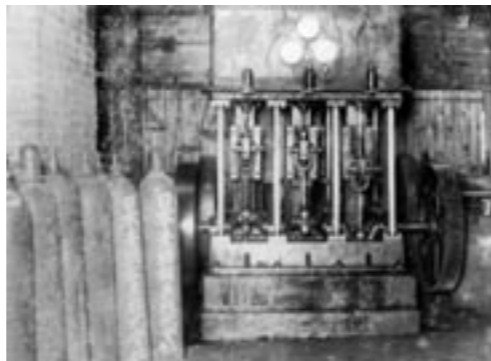
源泉から吸い上げた天然ガスをポンペに充填している様子 (写真提供・アサヒ飲料株式会社)
