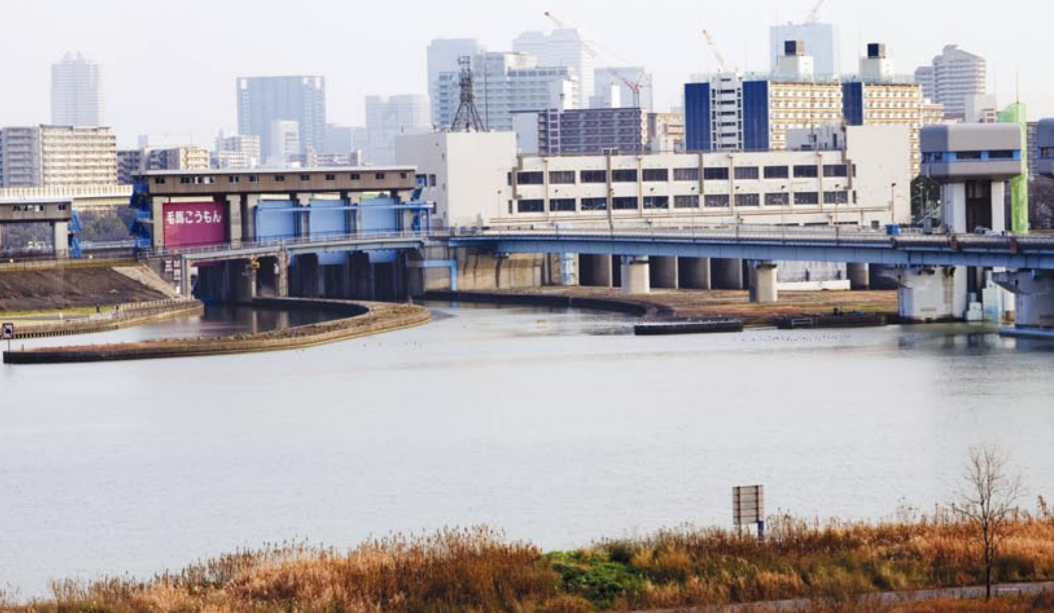
水位に差がある旧淀川と新淀川を行き来する船の航路を確保し、また旧淀川に流れ込む土砂や水量を制御するため、明治40年に建設された毛馬閘門。現在の毛馬閘門は昭和58年に建設されたもの。
