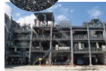
発生した汚泥を溶融スラグにする汚泥溶融設備
