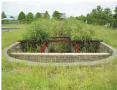
実験施設の全景 左側・右側:浚渫改良土、中央:川砂(在来工法)
