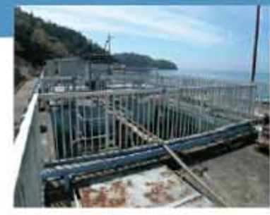
生活排水は、島の東部にある浄化センターで処理される。
