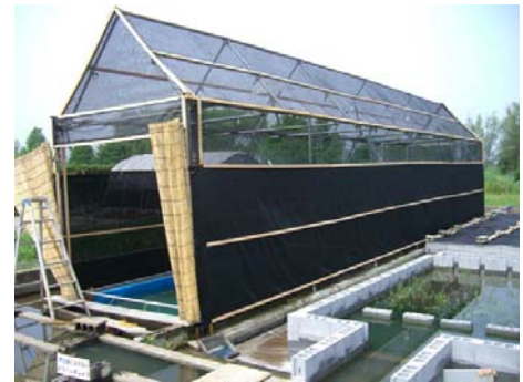
写真 3-2 暗幕の設置状況
