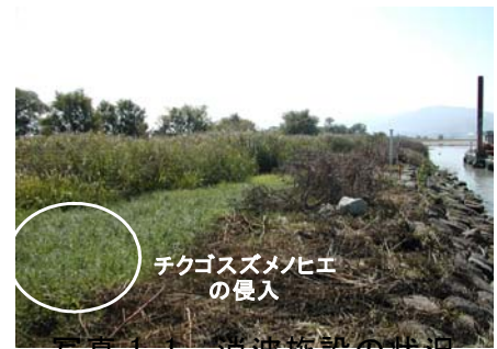
写真 1-1 消波施設の状況
