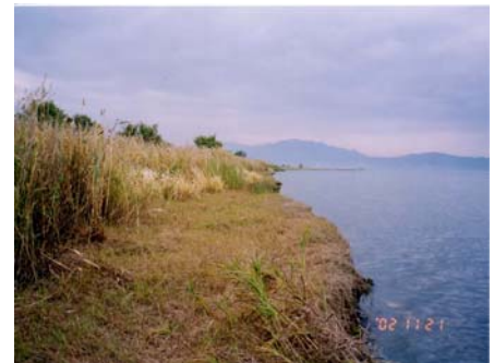
写真 1-2 消波施設撤去直後
