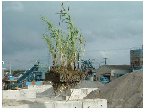
(b) 植栽基盤の運搬の様子
