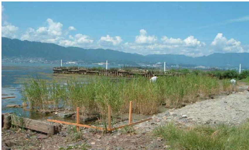
写真 4-5 琵琶湖湖岸へのヨシの植栽完了状況
