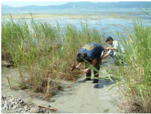
(c) 木杭の打設
