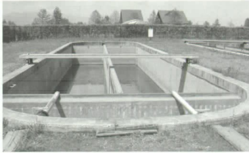
写真 4-1 深池型浄化実験施設 全景
