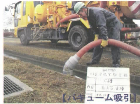
図 3-4-2 流入配管の吸引による回復作業
