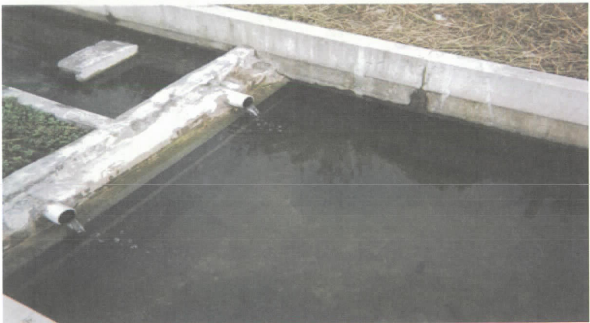
图 3-8 实验设施流出部（处理水槽）
