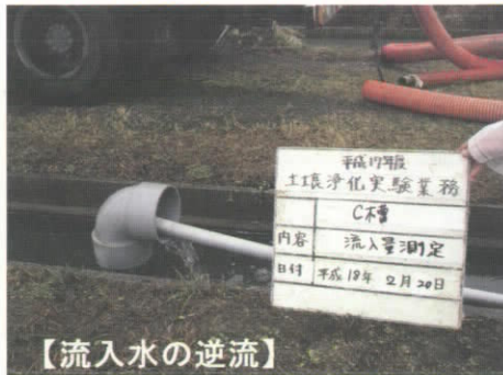
図 3-4-2 流入配管の吸引による回復作業
