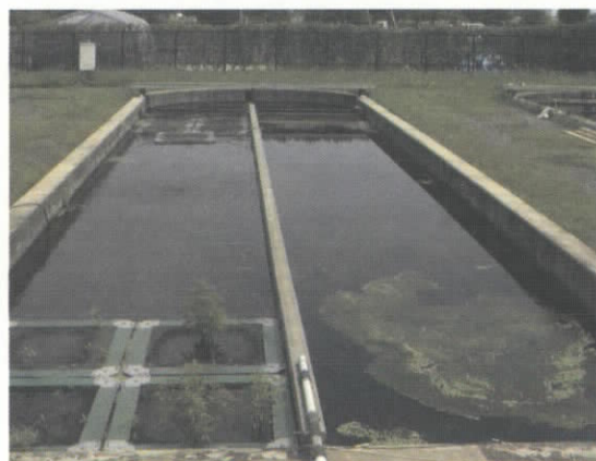
図 3-28 BRI 槽（左）と対照槽（右）
