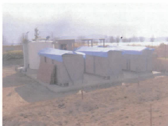
図 7-4 浸透ろ過施設外観
