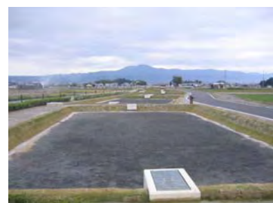
土壌浄化施設
