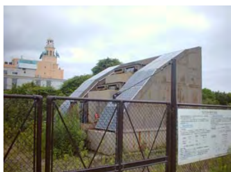
太陽光発電利用浄化施設
