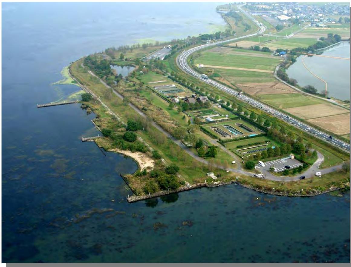
琵琶湖・淀川水質浄化共同実験センター（平成 18 年 10 月撮影）
