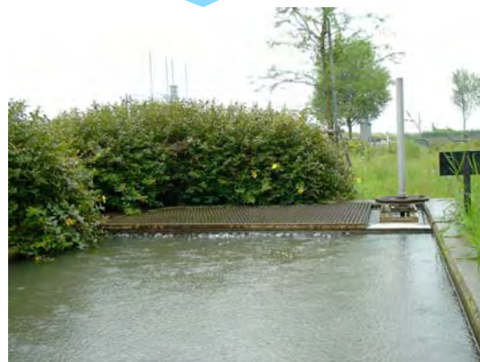
流入水路吐出口
