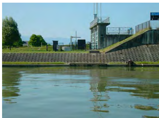
葉山川河口部ポンプピット
