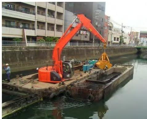
写真 市内河川の底泥浚渫（左；寝屋川、右；平野川、大阪府HPより）
