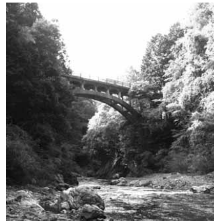
【桂川上流（清滝川落合橋）】
