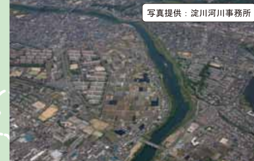
⑨ 隠元橋付近（宇治川） 写真提供：淀川河川事務所
