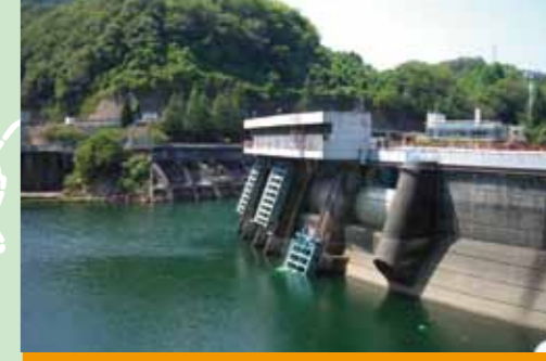
⑪ 瀬田川鹿跳橋
