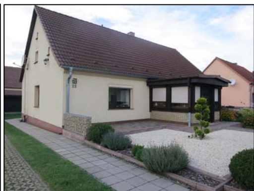
Technical Tour で視察した住宅の雨水対策
