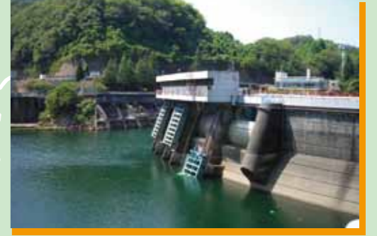
⑪ 瀬田川鹿跳橋
