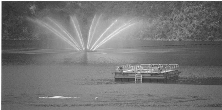
布目ダムでは良好な水を供給する為に水質保全施設を備えています。深層水の無酸素化、藻類対策として深層曝気施設、表層の藻類対策として浅層循環施設を設置しています。冷水や濁水対策には、選択取水設備を使用しています。
